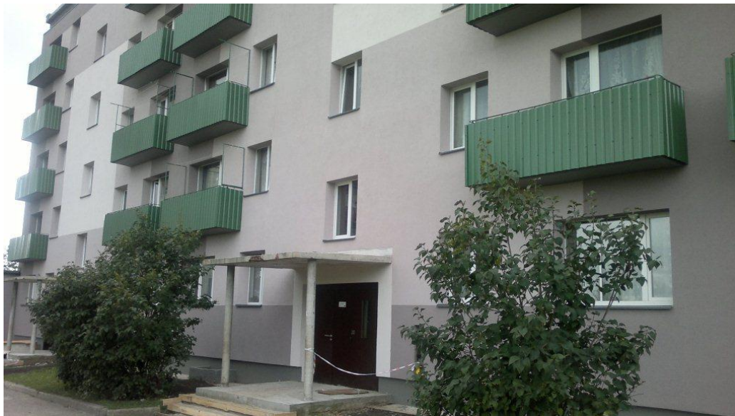
2.att.Jēkabpils, Slimnīcas ielas 4 daudzdzīvokļu māja renovācijas procesā
